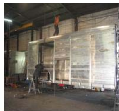
Fig-12 Colocación cortinas 3
