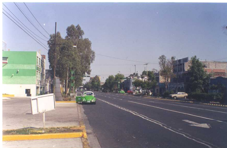
Figura 2.16 Vista Este de la Av. Canal del Norte
