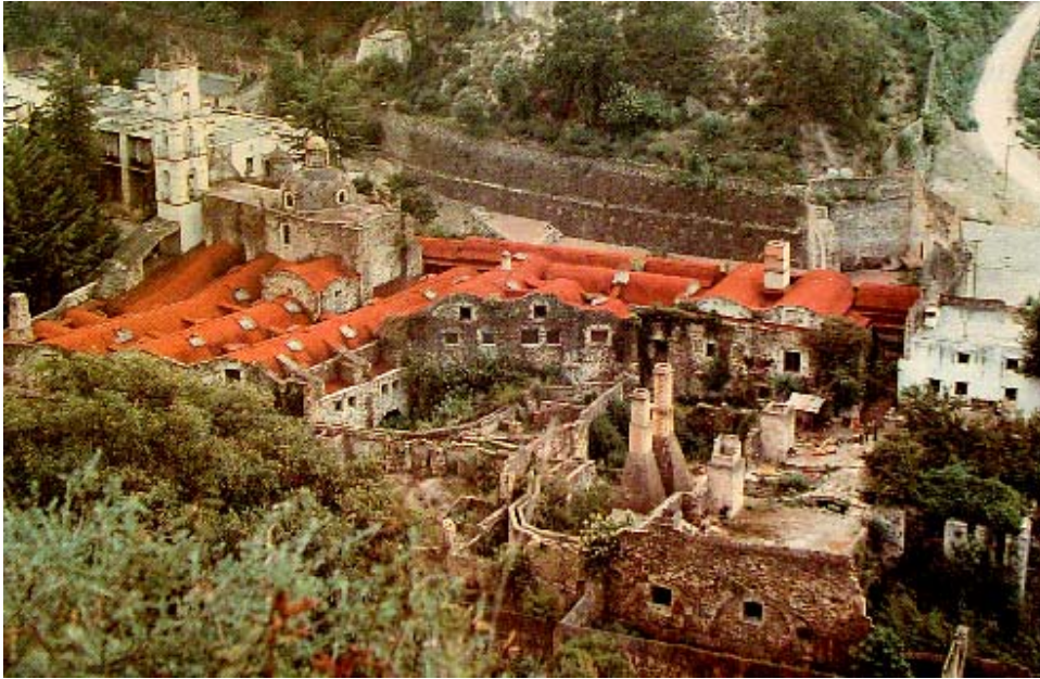
Hacienda de Santa María Regla. Hidalgo. Vista Aérea del conjunto
