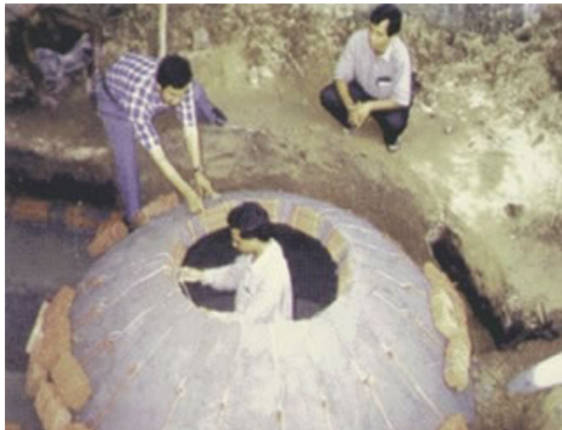
Fig. 2.2.2.(2). Biodigestor fijo en construcción.
