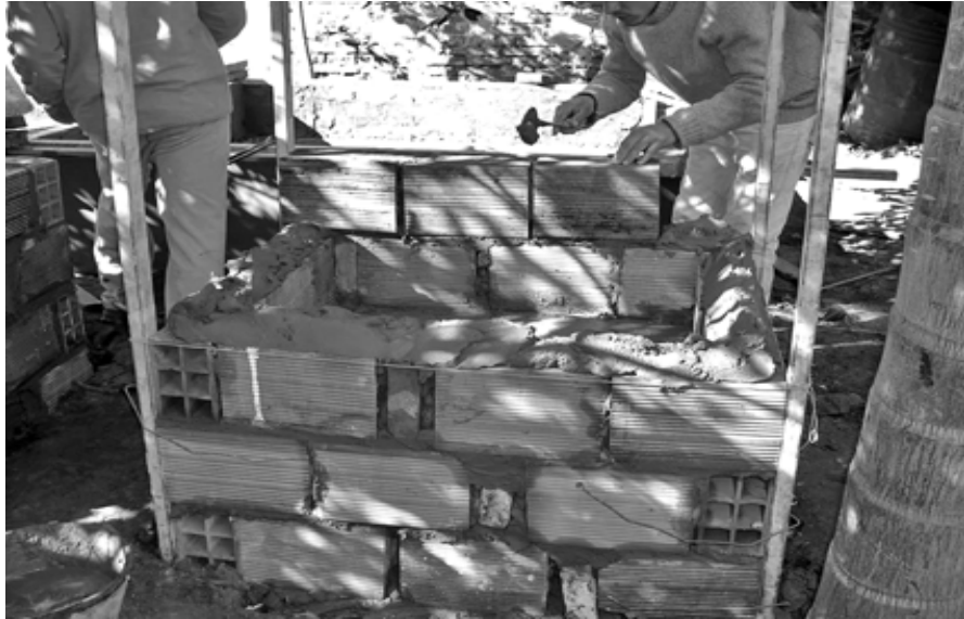
Fig. 2.6.3. ( 4). Construcción del tanque de alimentación.
