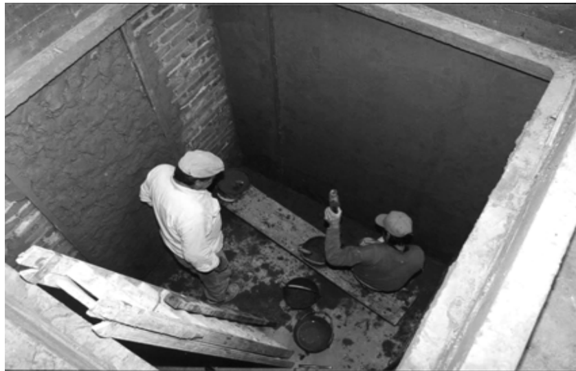
Fig. 2.6.3. (2). Construcción de la cámara.
