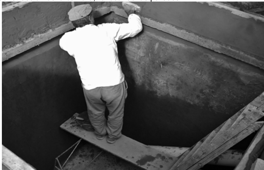
Fig. 2.6.3. (3). Construcción de la cámara, revocando las paredes.
