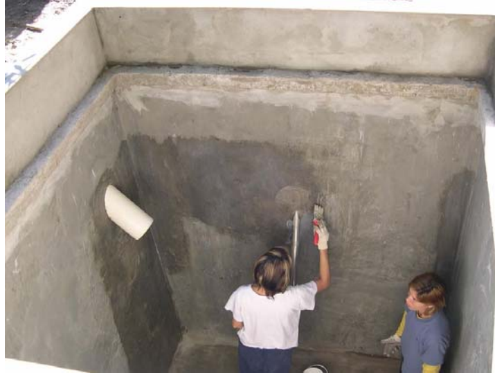
Fig. 2.6.4. (2). Impermeabilizado del tanque.
