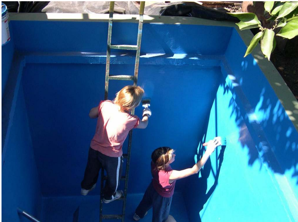
Fig. 2.6.4. (1). Sellado del tanque.
