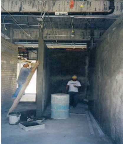
- Estructura de Concreto. - Albañilería.
