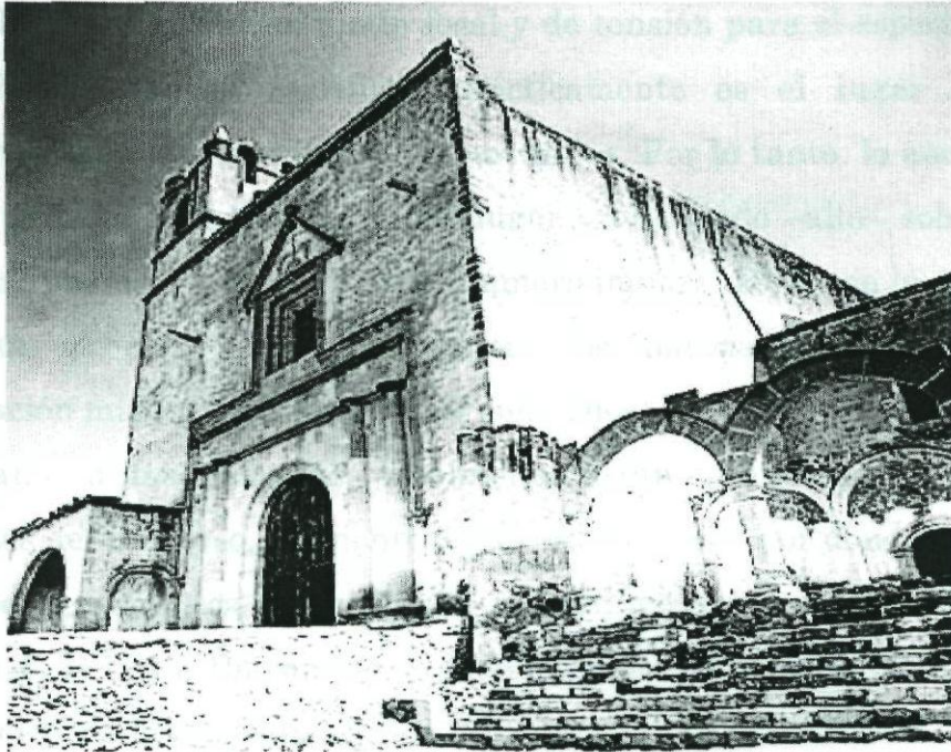
La firmeza del convento e iglesia de San Andrés, fue lograda fundamentalmente con la estructura del mismo. Símbolo de suma importancia para la implantación del evangelio cristiano.
