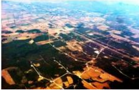
FIGURA 3. Vista aérea de la central Oaxaca I, II y III.
