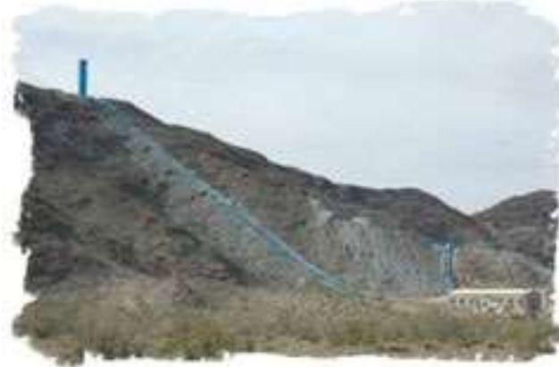
Acueducto Río Colorado
