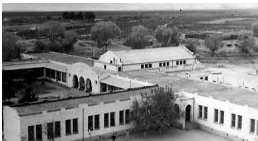
Instalaciones de la Escuela Normal Rural de Salta, Chihuahua.
