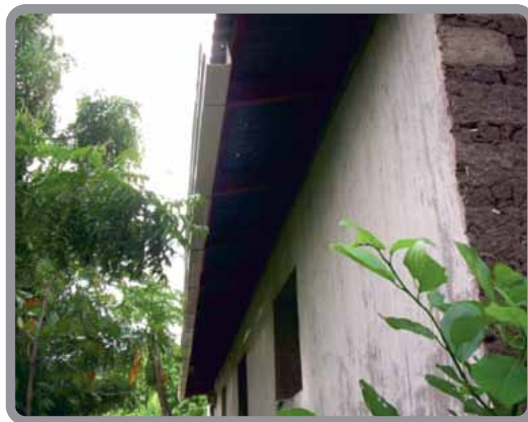
Figura 6. Captación de agua de tejados
