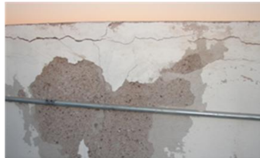
Muro en la parte alta del edificio de molienda
