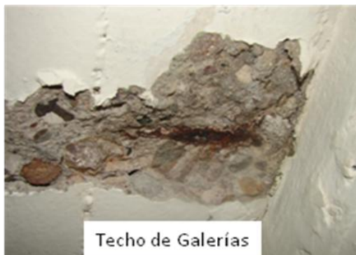
Foto1. Deterioros encontrados durante la inspección
