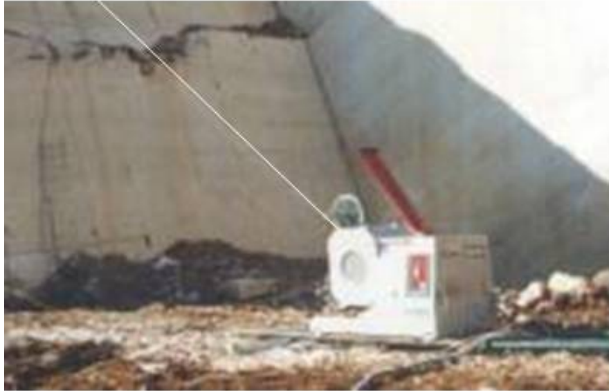
Figura 4. Rozadora de cable (hilo diamantado).
