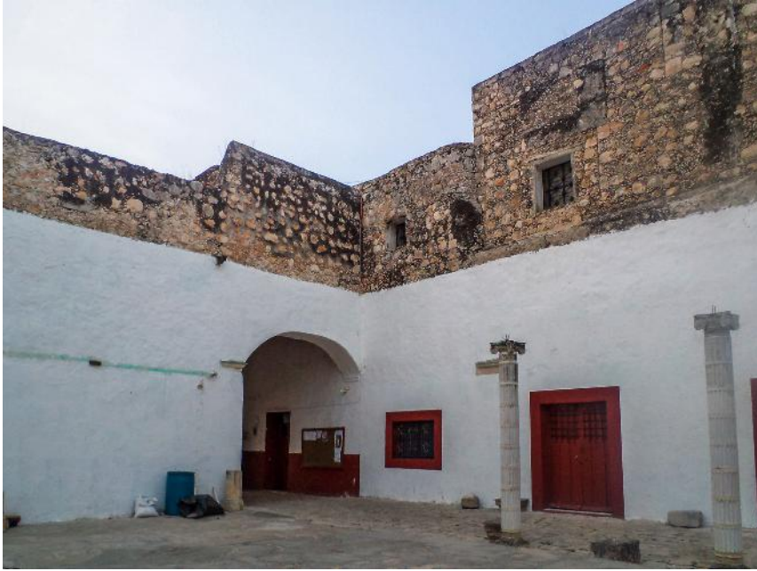
Imagen 409. El claustro construido en el siglo XVI.
