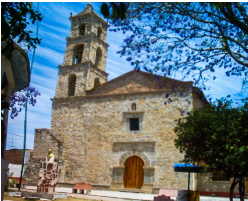
Imagen 201. La capilla de San Francisco de Asís Coatepec, construida en el siglo XVI. Coatepec es un barrio de Zitácuaro.
