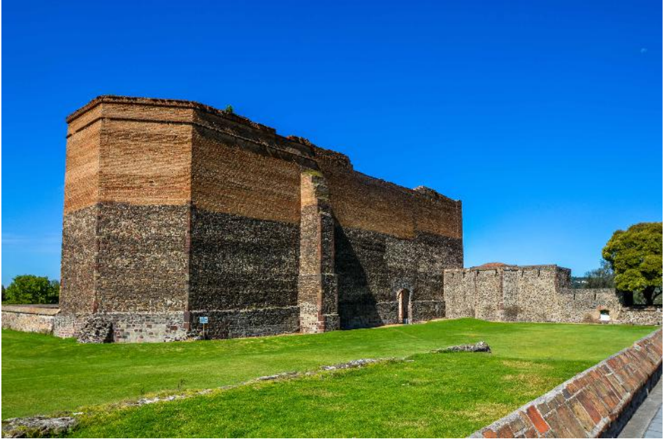
Imagen 297. Ruinas de la iglesia.
