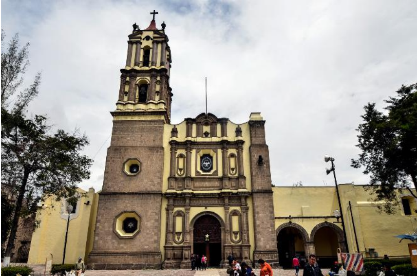
Imagen 61. La iglesia catedral construida en el siglo XVIII.
