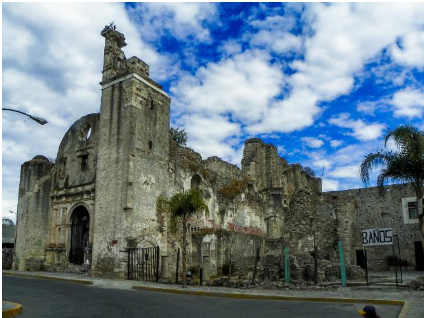
Imagen 388. Ruinas de la iglesia y la portería.
