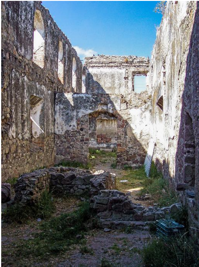
Imagen 352. Ruinas del convento.
