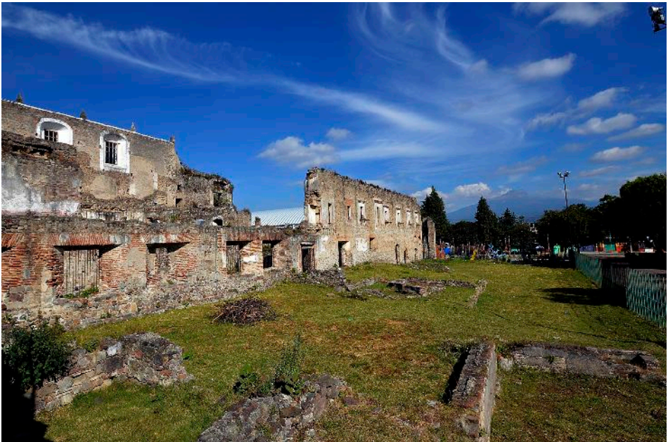
Imagen 351. Ruinas del convento.
