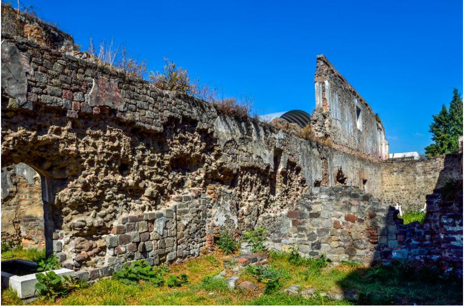
Imagen 350. Ruinas del convento.
