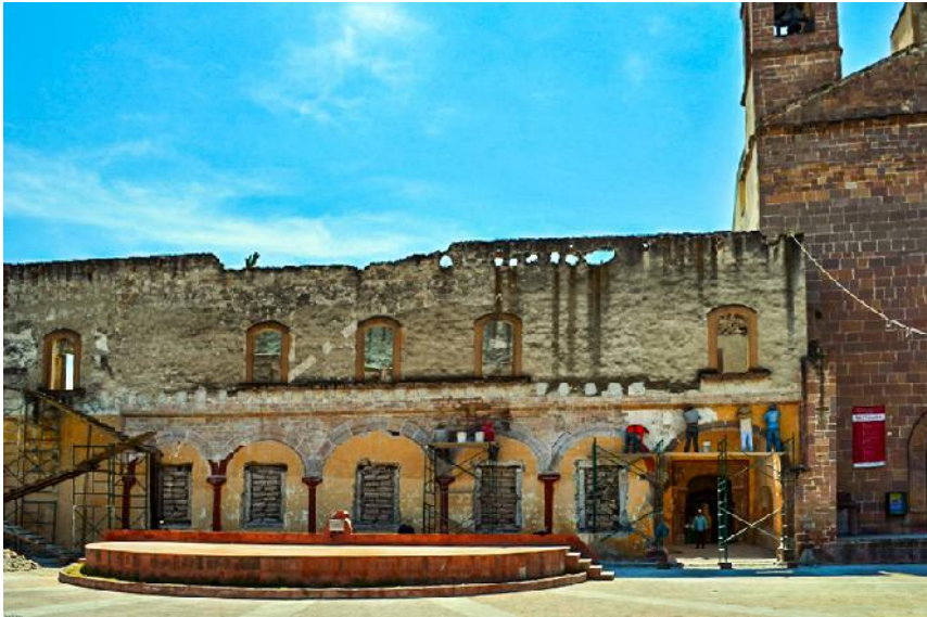
Imagen 161. Restauración del portal.
