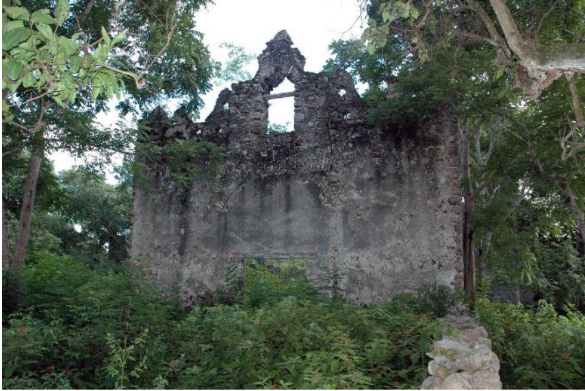
Imagen 434. Las ruinas de la capilla de indios construida en el siglo XVI.
