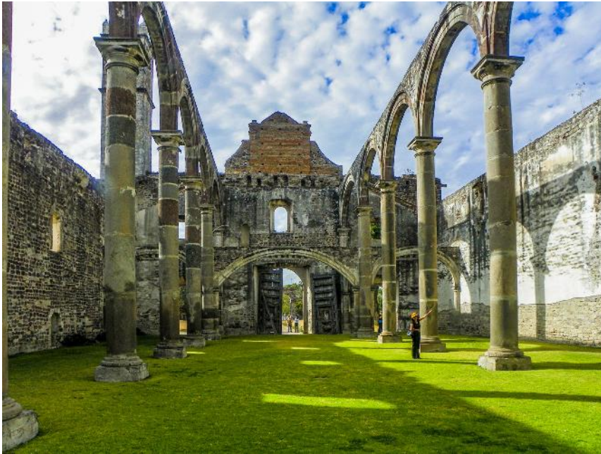
Imagen 360. Interior de la iglesia.
