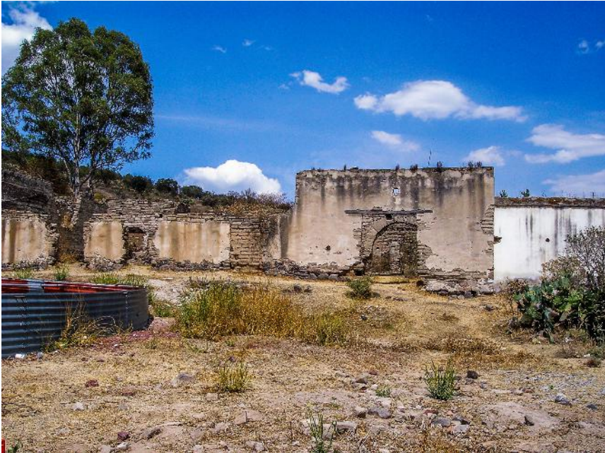
Imagen 296. Ruinas del convento.
