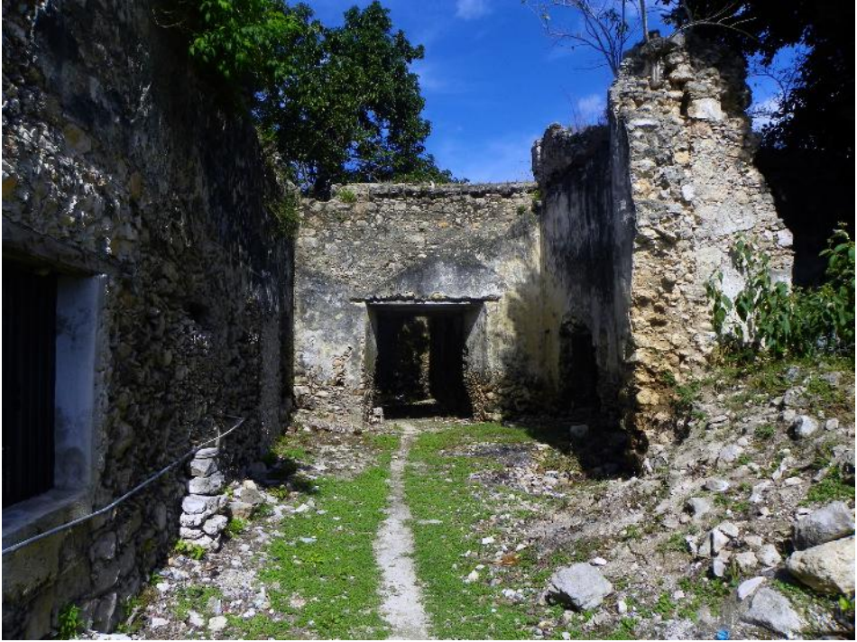
Imagen 425. Ruinas del convento.
