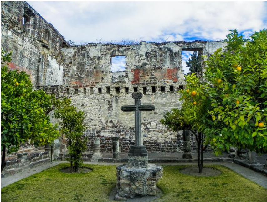
Imagen 361. Ruinas del convento.
