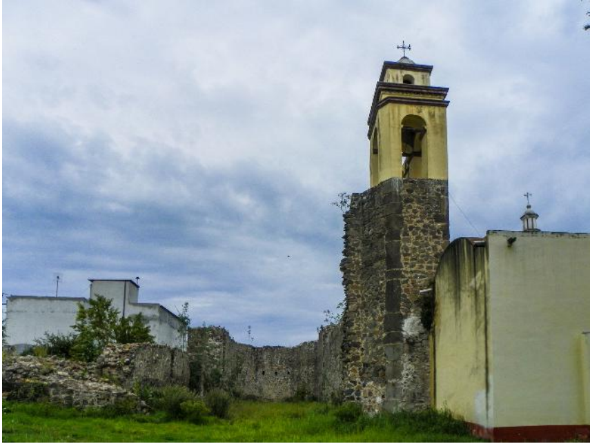
Imagen 345. Ruinas de la iglesia.
