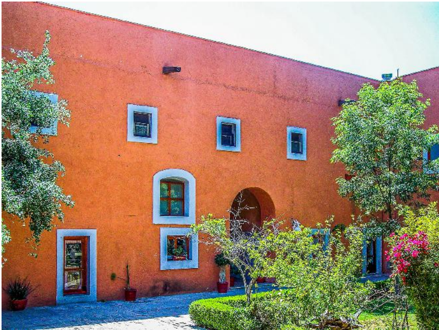
Imagen 516. Detalle del claustro.
