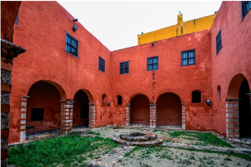
Imagen 416. El claustro construido en el siglo XVI.
