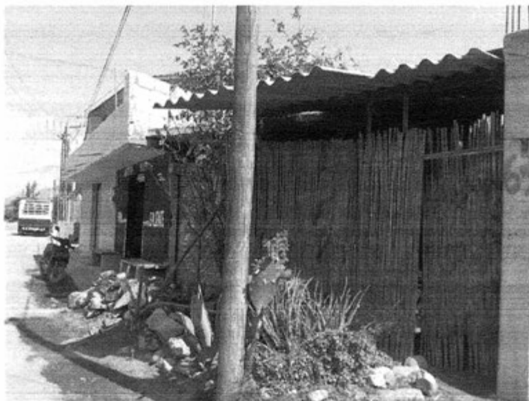
Vivienda con muros de carrizo y techo de lámina
