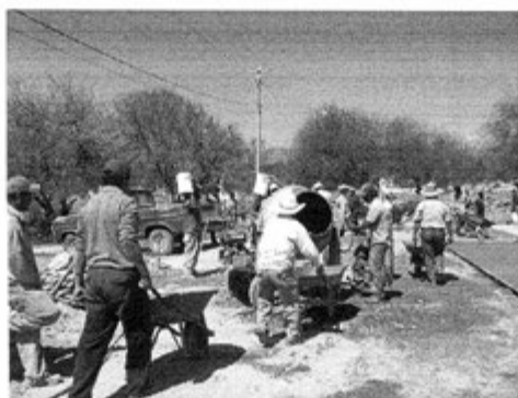
Pavimentación de calles durante las faenas
