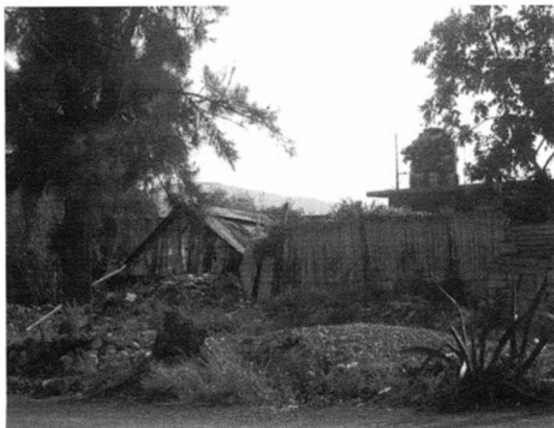
Casa con lámina de metal, y barda de carrizo para delimitar la propiedad
