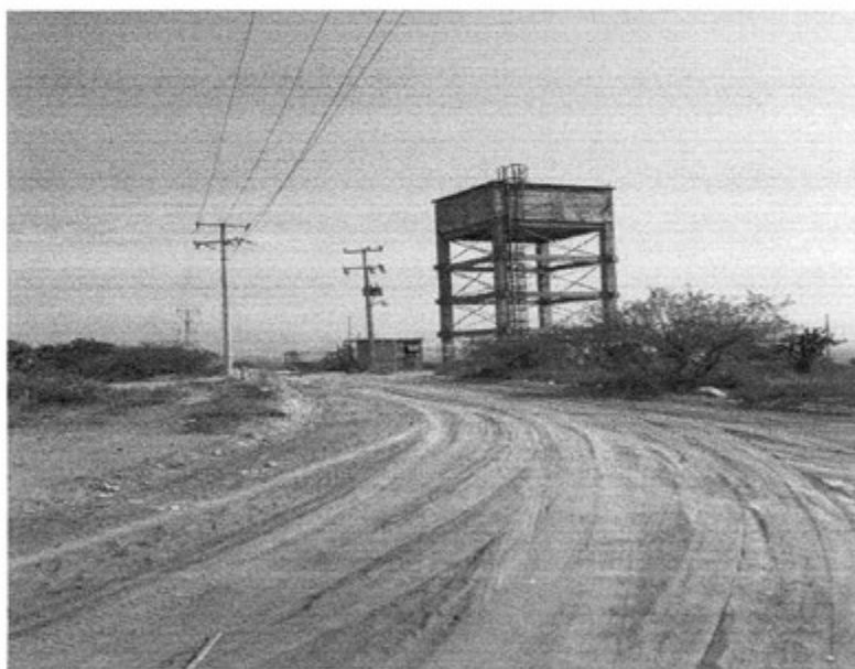
Tanque de agua potable que abastece a la localidad
