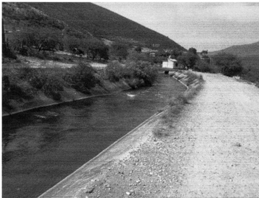
Canal de riego
