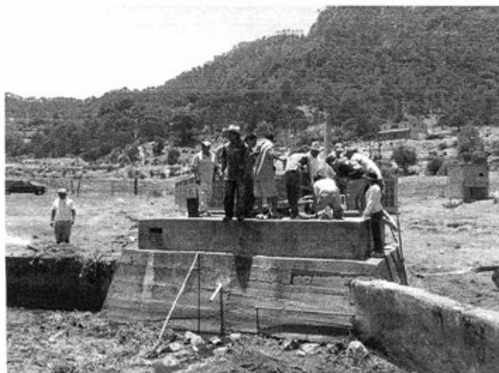
Faena, limpieza del depósito de agua
