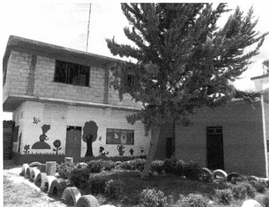
Instalaciones de escuela primaria, preescolar y delegación provisional.
