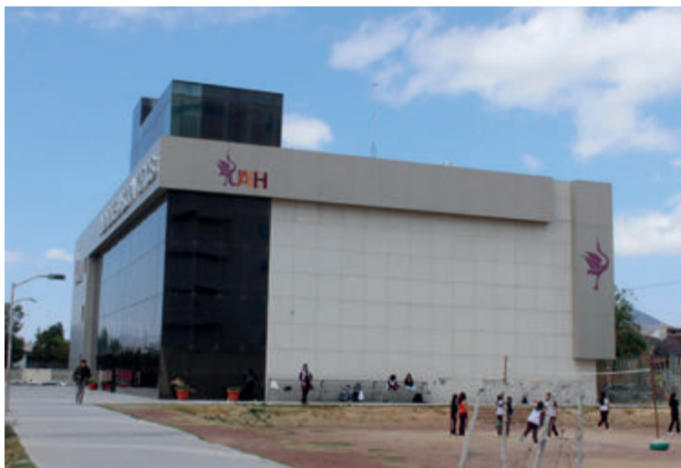
Edificio de laboratorios.
