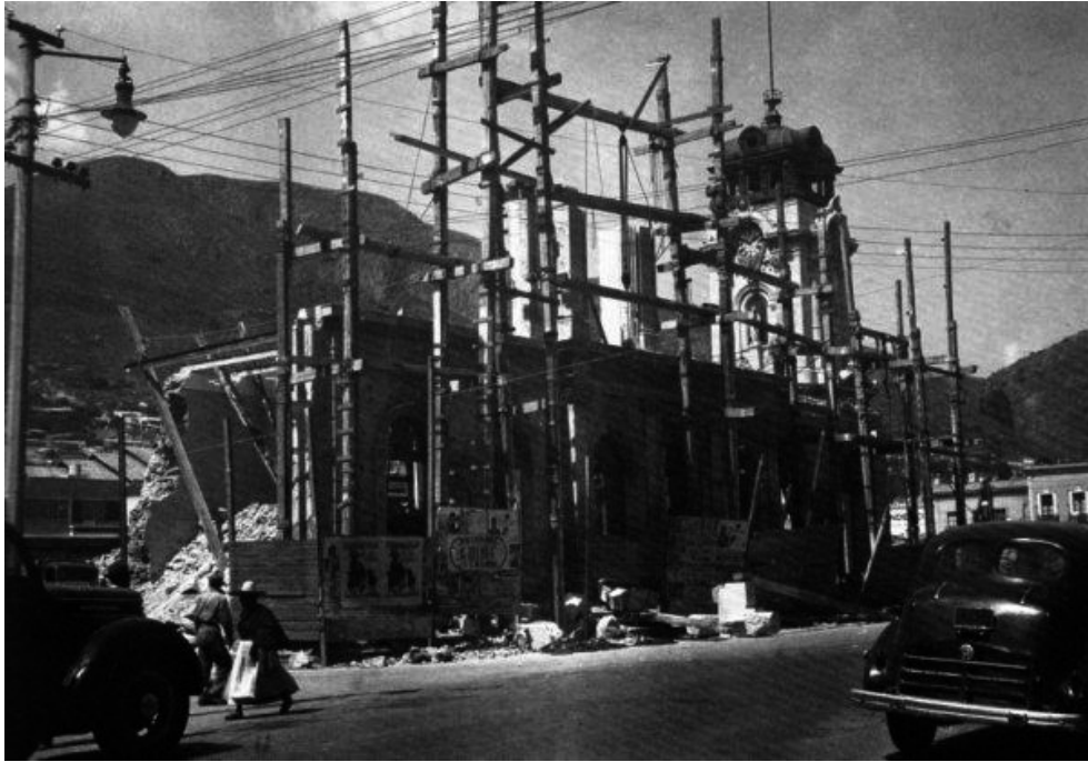
Demolición del Teatro Bartolomé de Medina. 1943
