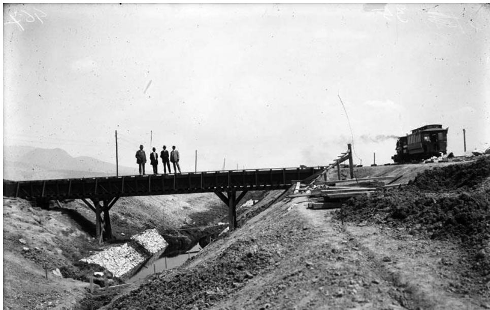
Foto 1: Puente de ferrocarril que da servicio a la obra hidráulica del tajo de Nochistongo, SINAFO.
