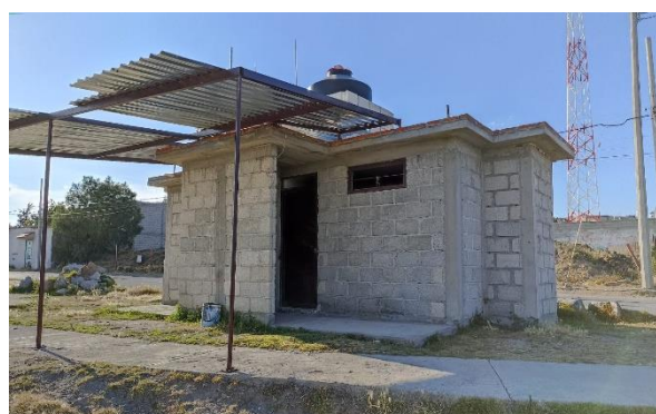
Figura 17 Sanitarios. Fuente propia
