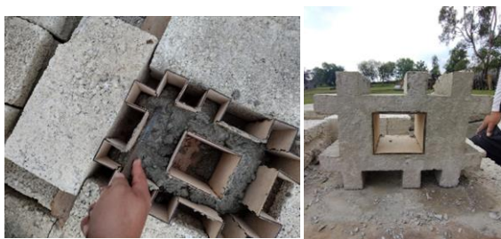
Figura 2. Construcción del muro verde.
