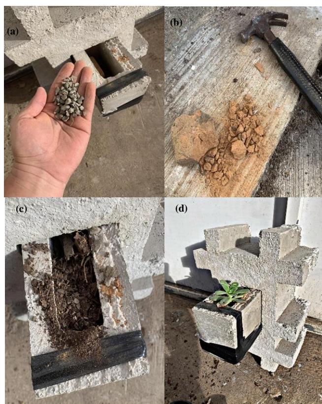
Figura 3. Instalación de un módulo del muro verde. a) Relleno de gravas (concreto triturado), b) Relleno de arenas (tabique rojo), c) Relleno de suelo vegetal y d) Módulo y maceta instalados.
