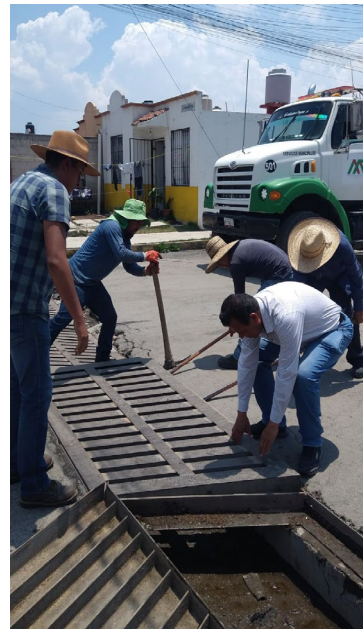
Figura 6. Desazolve de rejilla pluvial en Av. Mineros zona vulnerable de inundación con el vector municipal. Fuente: creación propia.
