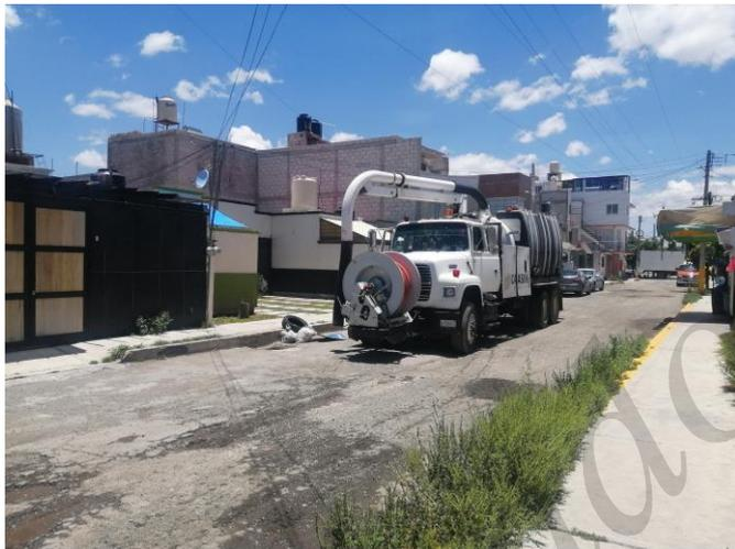
Figura 7. Desazolve de rejilla pluvial por parte de CAASIM. Fuente: creación propia.
