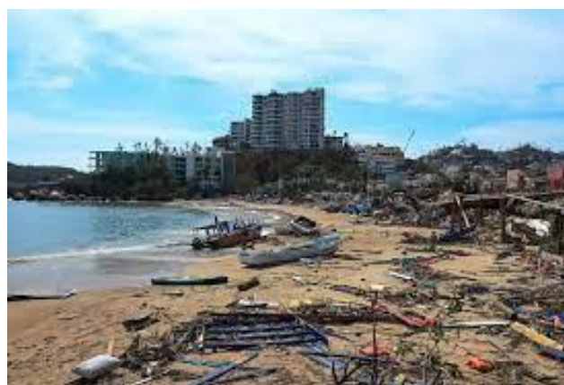
Figura 8. Destrucción de puertos y playas debido a huracanes.
