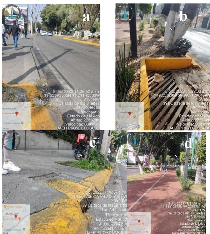
Figura 5: a) Obra de alcantarilla en buen estado, b) Obra de alcantarilla con basura, c) Obra de alcantarilla con azolve al 50%, d) Propuesta de lugar para adaptar SUDS.
