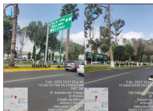
Figura 5: Alcantarillado sobre vialidad (fuente propia).
