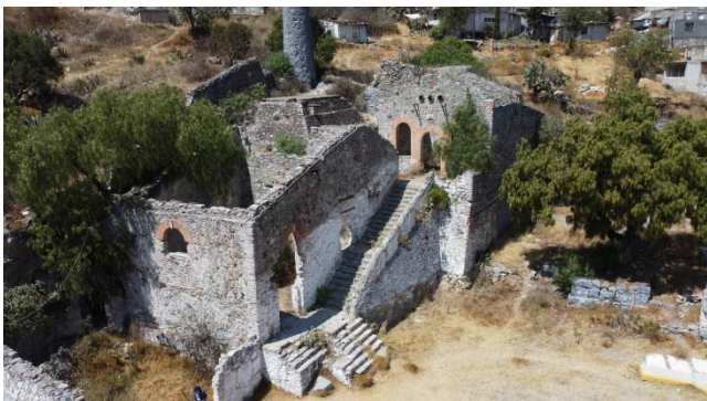
Figura 18: Mina Camelia, sala de calderas en primer plano y casa de bombeo con marcos de tabique. Trabajo de campo con vuelo de dron marzo, 2022. Fotografía de autor.
