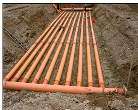
Figura 3: Configuración de Rejilla (Bruni, 2014).
