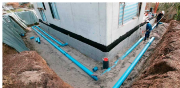
Figura 2: Configuración de Anillo (Bruni, 2014).
