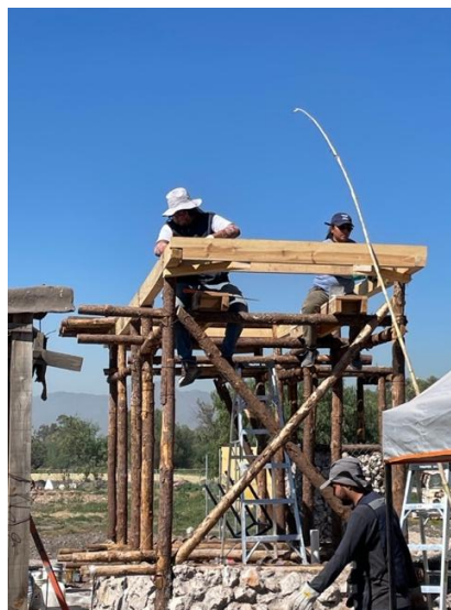
Imagen 3 GN Armado de la bóveda
