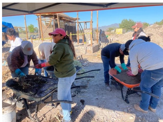
Imagen 5 Realización de mezcla para la bóveda
