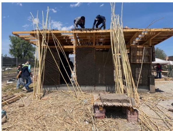
Imagen 4 GU y GD realizando la cubierta de los módulos habitacionales
