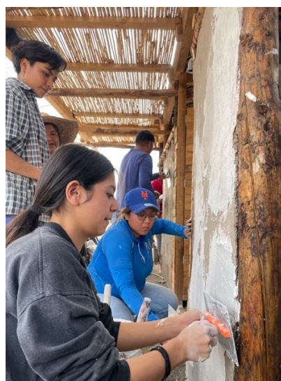
Imagen 6 Aplanado de muros
