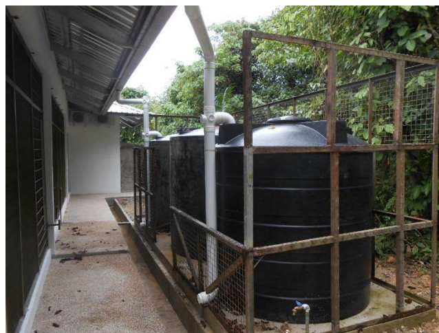
Figura 4: First Flush Diverter empleado en una complejo departamentario.
