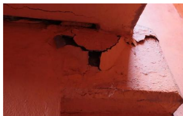
Figura 2. Interior de vivienda social con filtraciones y grietas. El Rosario, Ciudad de México. Tomada de Reforma (2024).
