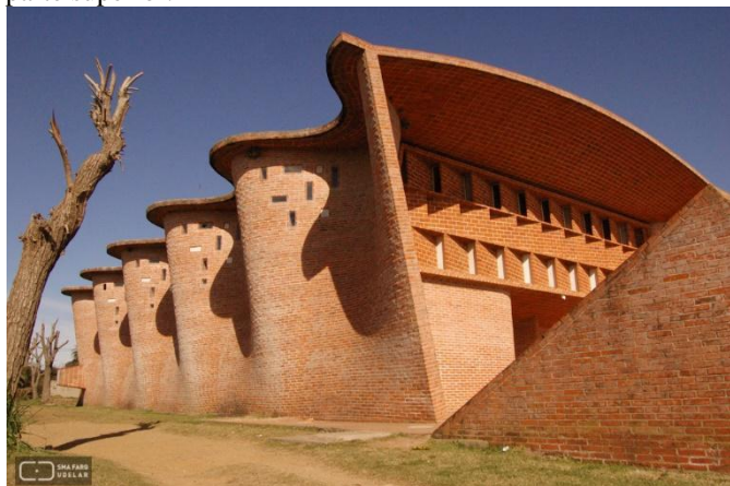
Figura 3. Fotografía en perspectiva de la iglesia, la parte superior de los muros son los aleros que sostienen a la bóveda gausa. Imagen tomada de Facultad de Arquitectura, Universidad de la República, Montevideo, Uruguay, (2025) Eladio Dieste, Iglesia de Atlántida Cristo Obrero y Nuestra Señora de Lourdes, https://www.fadu.edu.uy/eladio-dieste/obras/iglesia-atlantida/
