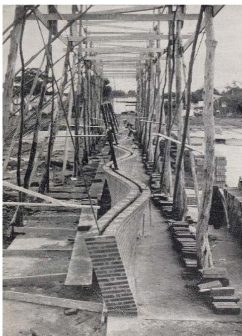
Figura 14: Representación de hilada doble para construcción del muro. Imagen tomada del libro, Eladio Dieste: La estructura cerámica, (p. 45) por Carbonell Galaor, 1987.
