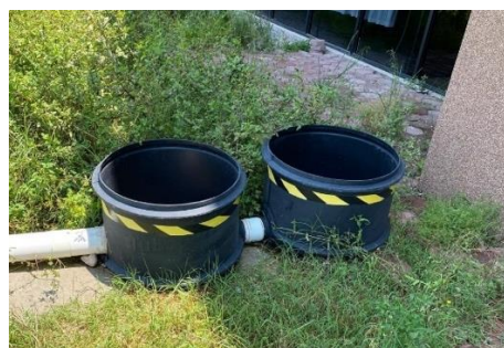
Figura 31. Registros adaptados como captadores de agua pluvial. Fuente: Autor.
