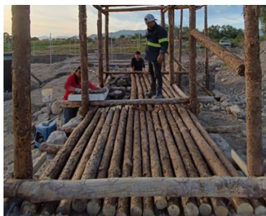
Figura 19: Elaboración de piso para módulo de baño seco y letrina. Fuente: Elaboración propia.
