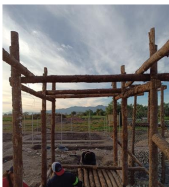
Figura 20: Colocación de traveses para baño seco y letrina. Fuente: Elaboración propia
