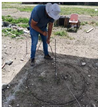
Figura 12: Trazo de fosa séptica. Fuente: Elaboración propia
