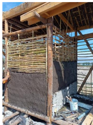
Figura 21: Elaboración de muros de bahareque para baño seco y letrina. Fuente: Elaboración propia.
