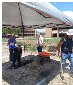
Figura 11: Excavación de zanja para cimiento. Fuente: Elaboración propia
