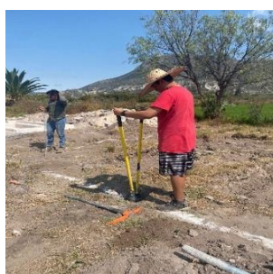
Figura 23. Colocación de cimentación para recibir el tubo galvanizado. Fuente: Elaboración propia.
