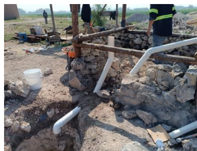
Figura 17: Instalación de tubería sanitaria. Fuente: Elaboración propia.
