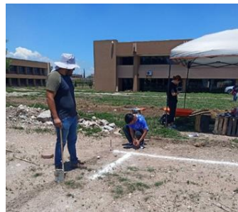
Figura 9: Trazo de módulo de baños. Fuente: Elaboración propia.
