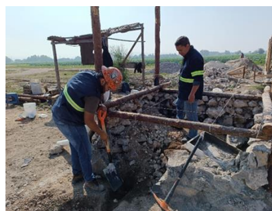
Figura 18. Colocación de morillo vertical. Fuente: Elaboración propia.
