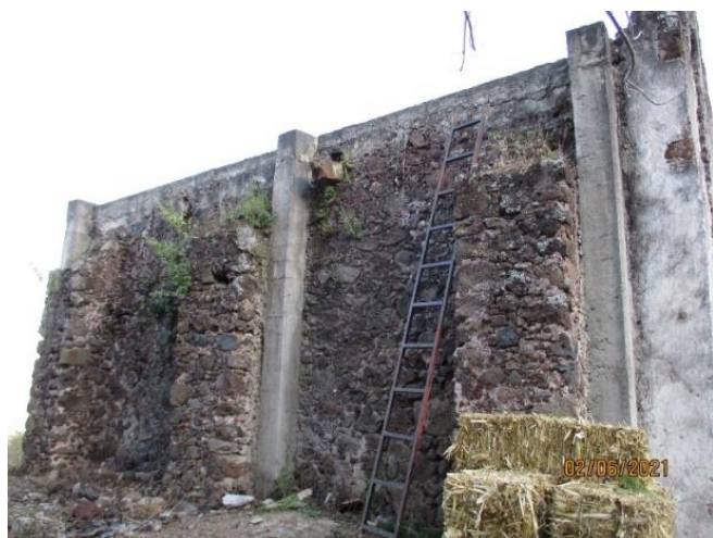
Gráfico 1 Fachada lateral donde se observan columnas de concreto armado formando un anillo estructural en la capilla de Santa Catarina, fuente ELA 2021
