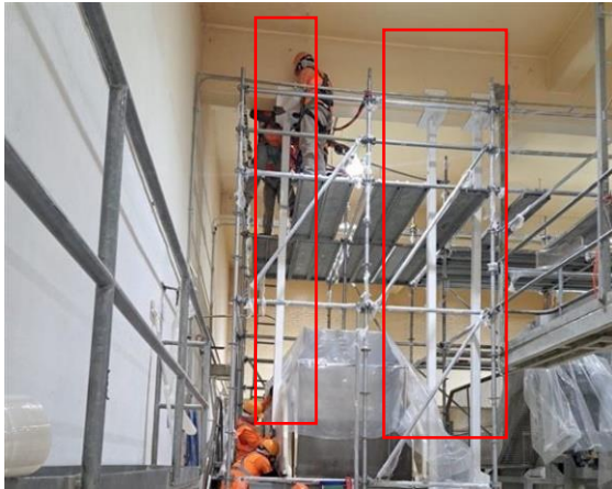
Figura 4: Instalación de soportes estructurales para equipo inamovible dentro de la losa a demoler. Fuente: Elaboración propia, 2025.
