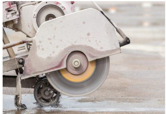
Figura 5: Representación del corte con disco diamantado en concreto como método de demolición. Fuente: Comportiz, 2023.
