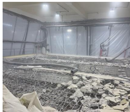
Figura 6: Contenciones con plástico en el área intervenida y mangueras de inyección y extracción de aire. Fuente: Elaboración propia, 2025.
