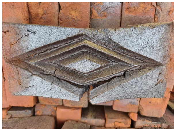
Figura 4. Fisuración por calentamiento y enfriamiento no uniforme en ladrillo decorativo, evidenciada por fisuras de origen térmico.
