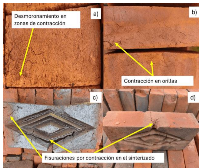
Figura 7. Tipos de defectos observados en los ladrillos.
