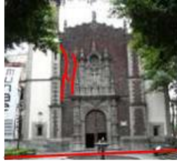
Figura 7a: Foto de fachada principal resaltando las fisuras más visibles en las fronteras de las torres campanario y la portada
