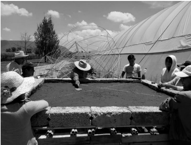
Imagen 8. Acabado final en colado de terrado
