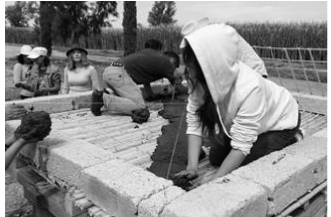
Imagen 6. Colocación de hilos y maestras
