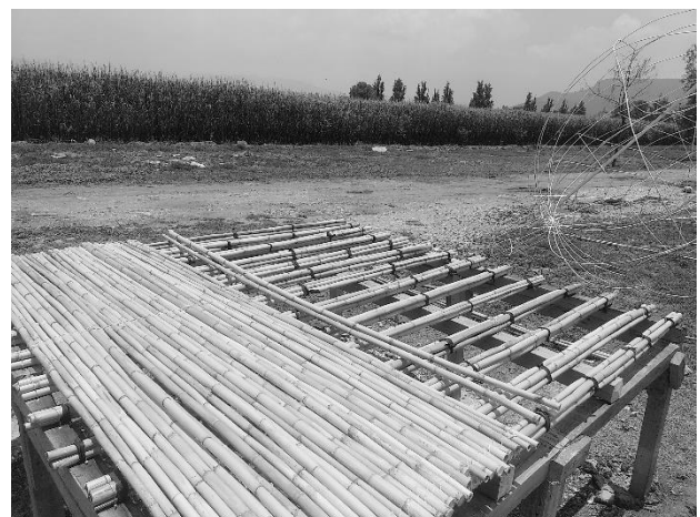
Imagen 1. Estructura de carrizo
