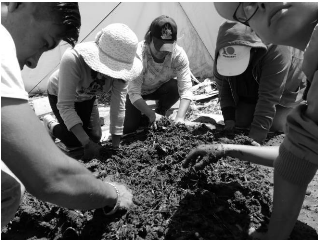
Imagen 5. Elaboración de mezcla
