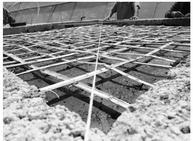
Imagen 7. Colocación de malla de cuartos de caña de carrizo
