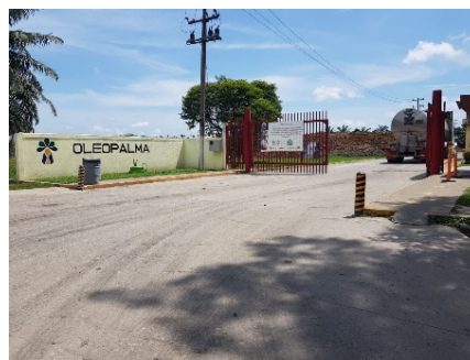
Figura 2: Fotografía del acceso a la fábrica extractora, pila de desecho de raquis a cielo abierto.
