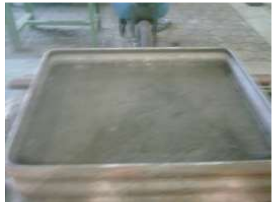
4.-Relleno con arena el cernidor rojo y se vuelve a compactar.
