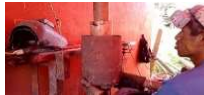
Imagen 11. Instalación del boiler
