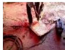
Imagen 6. Corte de una lámina para él comal de la hornilla
