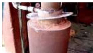
Imagen 11. Colocación tapa al cilindro térmico
