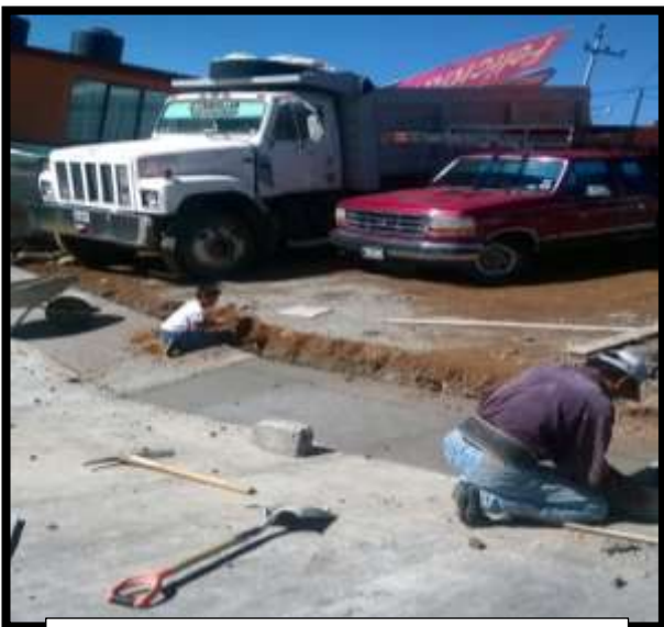
Al fondo de la foto apreciamos unos camiones de carga estacionados, frente a ellos dos obreros de la construcción, uno de ellos es un infante el cual se ve que remueve el exceso de tierra, frente a ellos observamos las herramientas que utilizan para llevar acabo el arduo trabajo.
