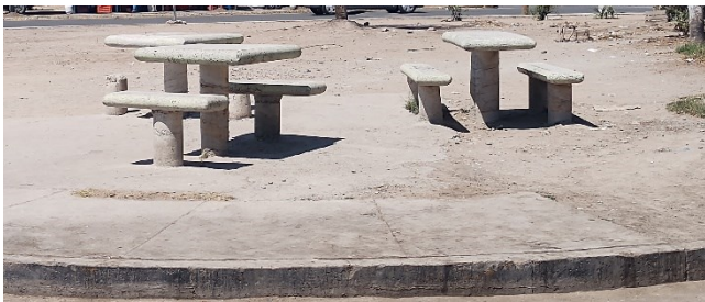
Figura. 1 espacio destinada como área verde sin mantenimiento,
