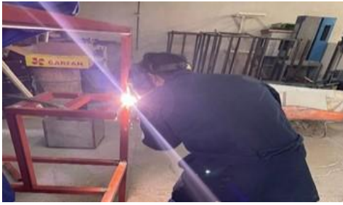
Figura 2. Unión por soldadura de la estructura. Fuente: Elaboración propia.
