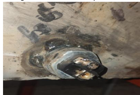
Figura 5. Instalación de la rosca para la resistencia. Fuente: Elaboración propia.
