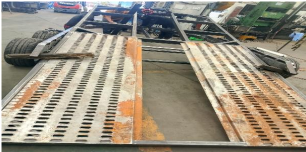
Figura 6. Ensamblando el piso. Fuente: Elaboración propia.
