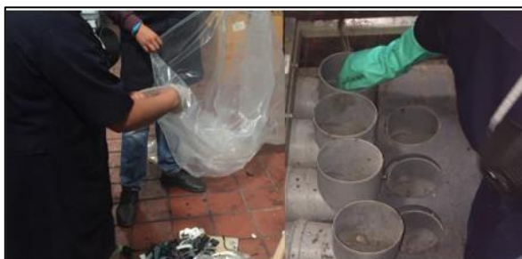
Figura 5. Limpieza del área de acabado.
