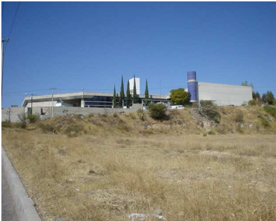
FOTOGRAFÍA No. 10: NEW COM DE MÉXICO S.A. DE C.V.
