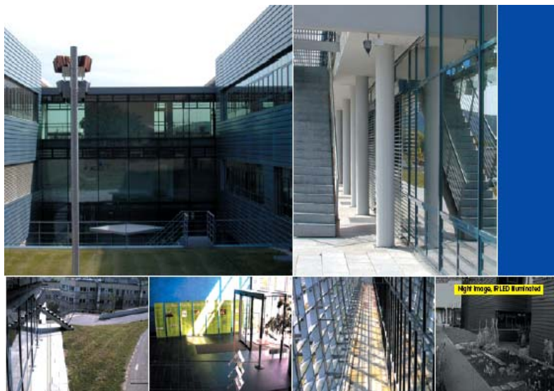
Fig. 4.12 Ubicación de las cámaras e imágenes de la transmisión de las mismas en el instituto.
